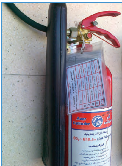
شکل ۱۰-۱- پلاک مشخصات و تاریخ شارژ نصب‌شده روی کپسول
