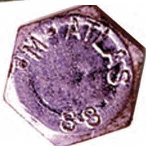
شکل ۱۵-۳ اعداد حک شده روی سر پیچ
