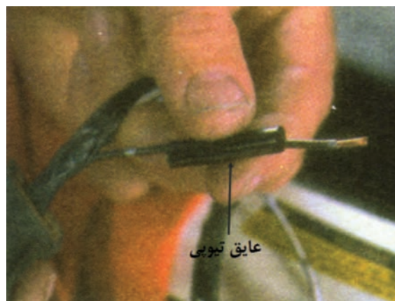
شکل ۶۳-۶- وارد کردن سیم به داخل عایق تیوبی
