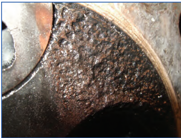
شکل ۲۷-۴- حفره‌های ایجاد شده بر اثر زنگ‌زدگی
